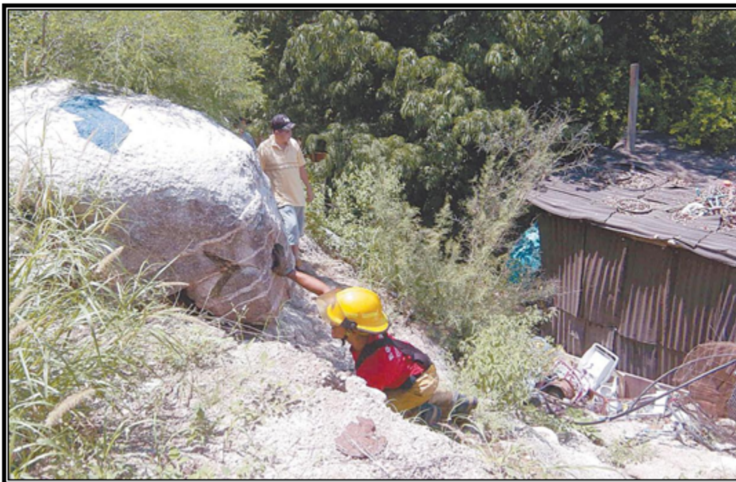
Figura 5.- Aquí se observa la posibilidad de una caída de roca y la cual puede llegar a provocar una desgracia en una de las colonias de Hermosillo.
