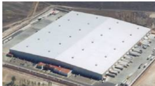
(a) Edificaciones industriales
