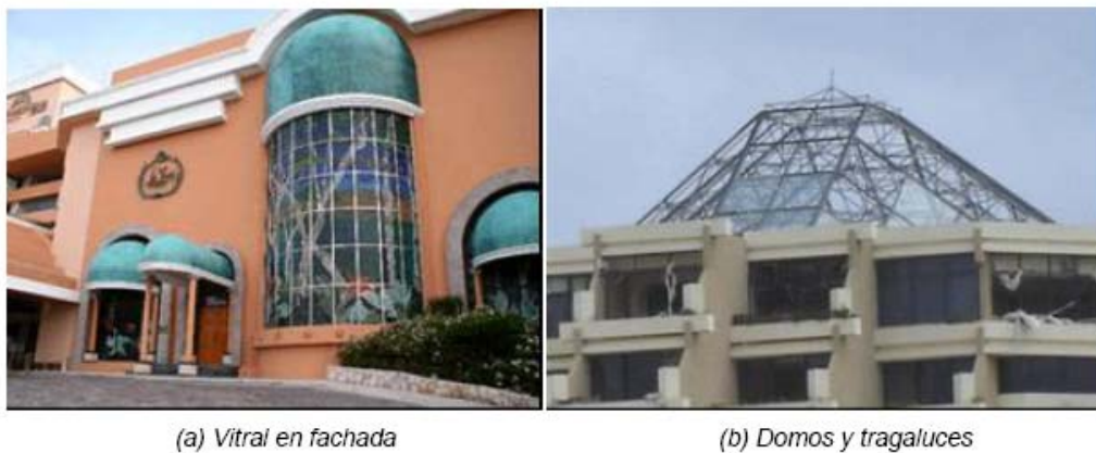
Figura 3-9 Ventanas y vitrales en fachadas, y domos y tragaluces
