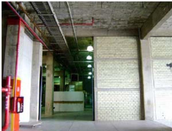
Figura A-2. Tipo estructural con columnas y traveses de concreto reforzado
