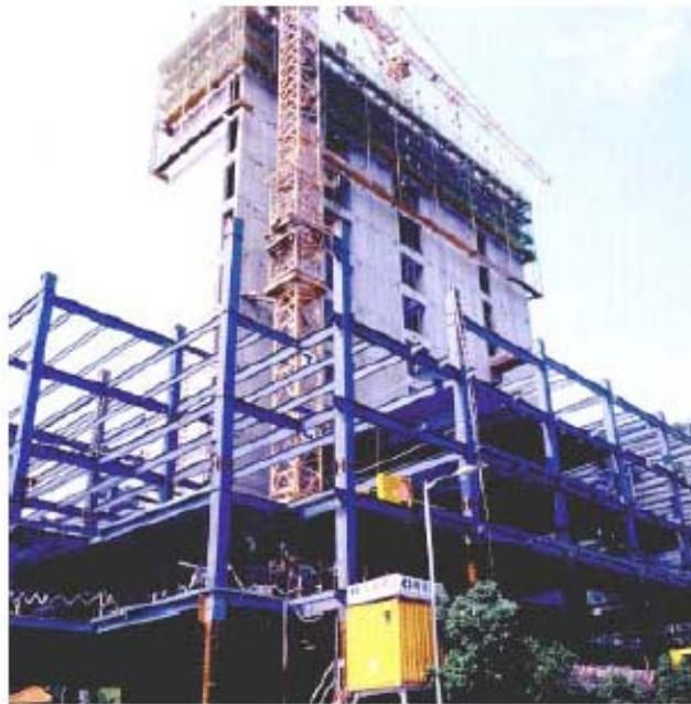
Figura A-7. Columnas y traves de acero estructural con muros de concreto
