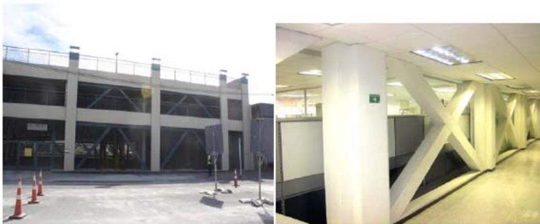
Figura A-4. Columnas y trabes de concreto con contraventeo: Izq. diagonales en el exterior y Der. diagonales en el interior
