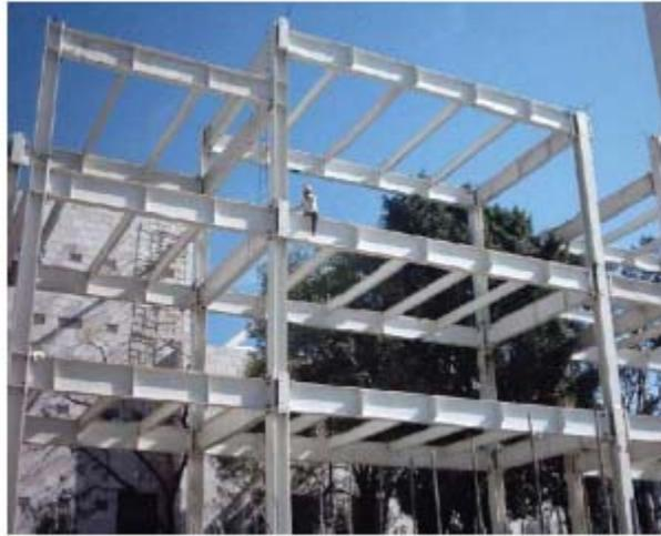
Figura A-5. Columnas y traves de acero estructural
