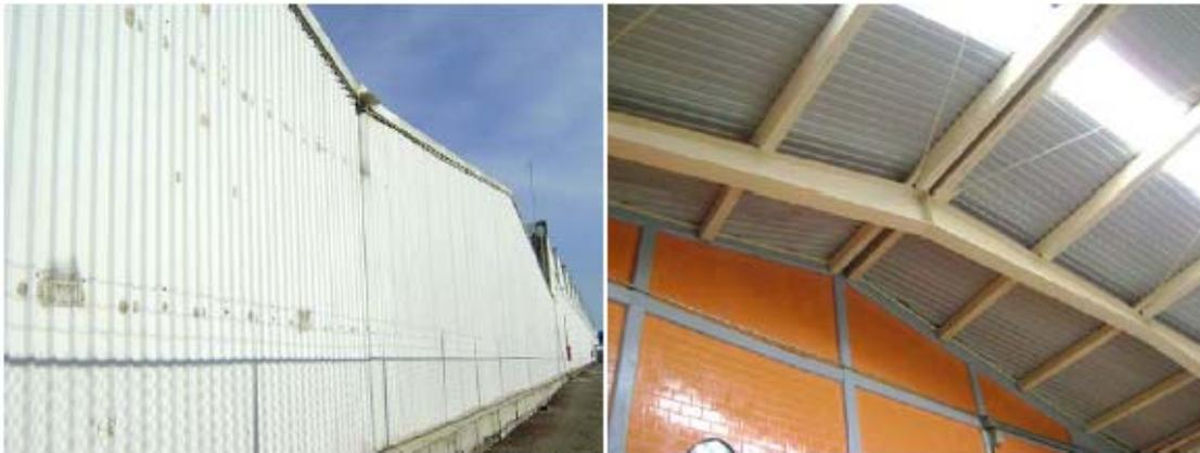
Figura A-10. Industriales de cubierta ligera: Izq. no rigidizada y Der. rigidizada
