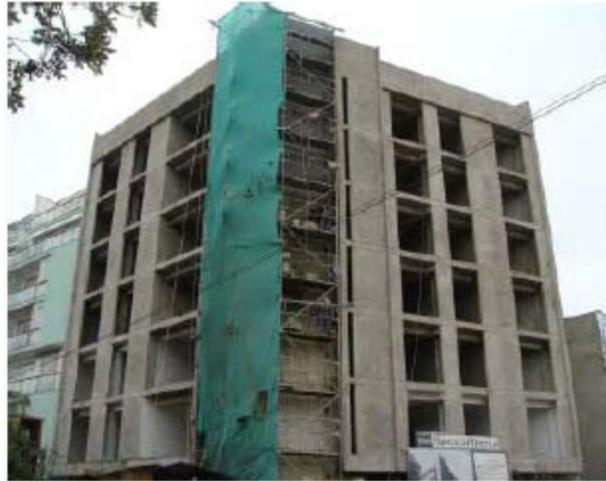
Figura A-3. Tipo estructural con columnas, trabes y muros de concreto reforzado
