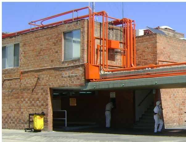
Figura A-1. Aunque este tipo estructural predomina en casa habitación, también se observa en construcciones para uso industrial
