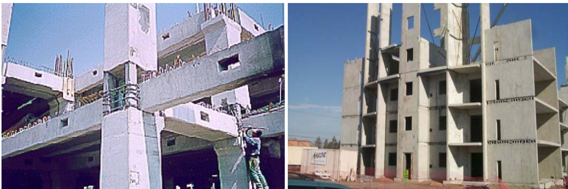
Figura A-9. Estructuras prefabricadas
