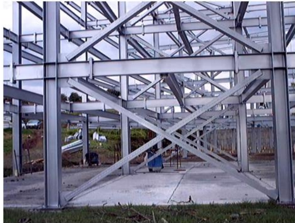
Figura A-6. Columnas y traves de acero estructural con diagonales de acero
