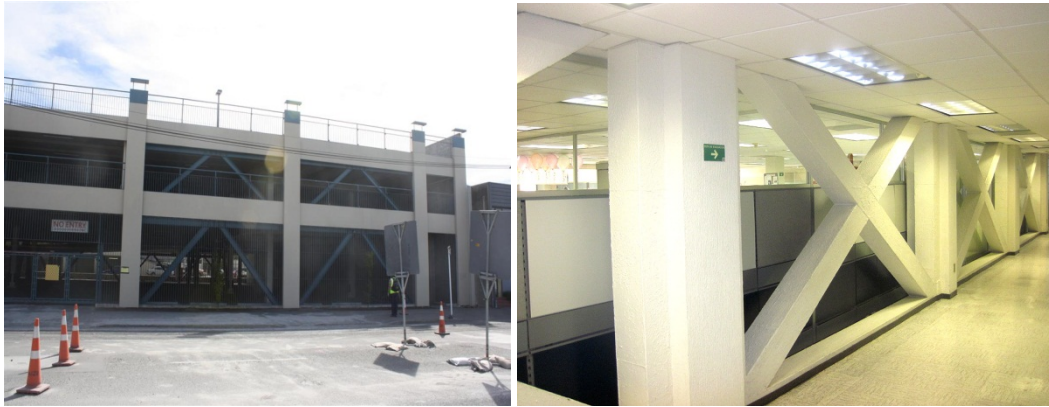
Figura A-4. Columnas y traves de concreto con contraventeo: Izq. diagonales en el exterior y Der. diagonales en el interior
