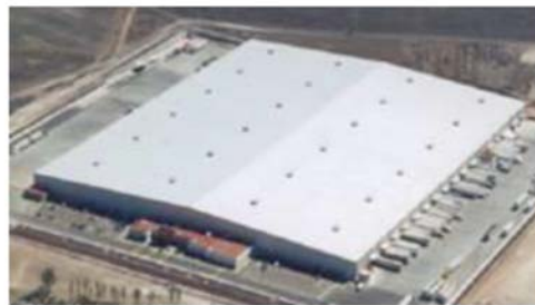
(a) Edificaciones industriales
