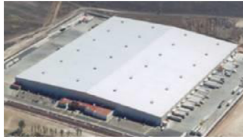
(a) Edificaciones industriales
