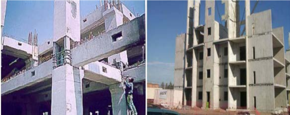
Figura A-9. Estructuras prefabricadas
