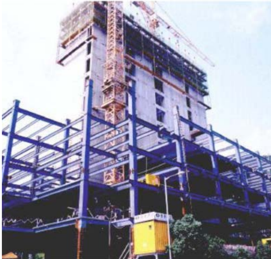
Figura A-7. Columnas y traves de acero estructural con muros de concreto
