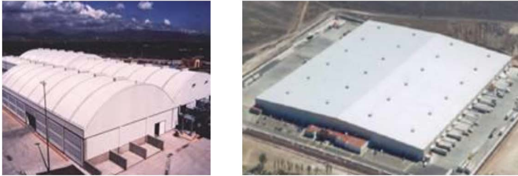
(a) Edificaciones industriales
