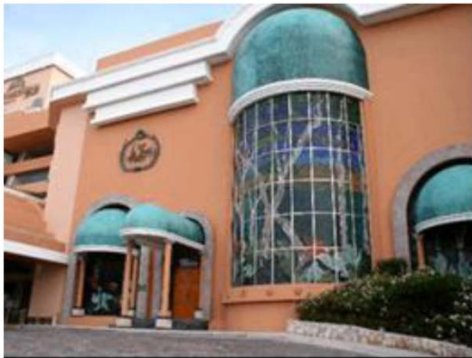
(a) Vitral en fachada
