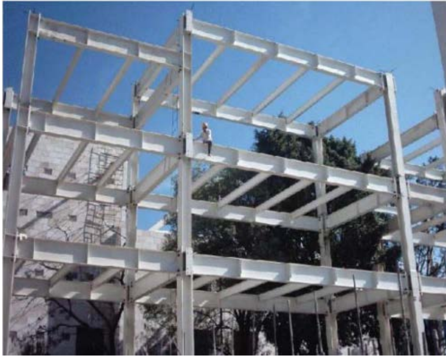
Figura A-5. Columnas y traveses de acero estructural
