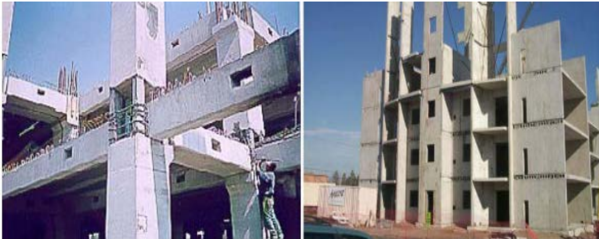
Figura A-9. Estructuras prefabricadas
