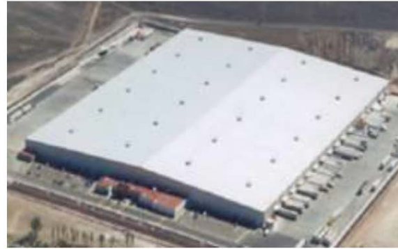
(a) Edificaciones industriales
