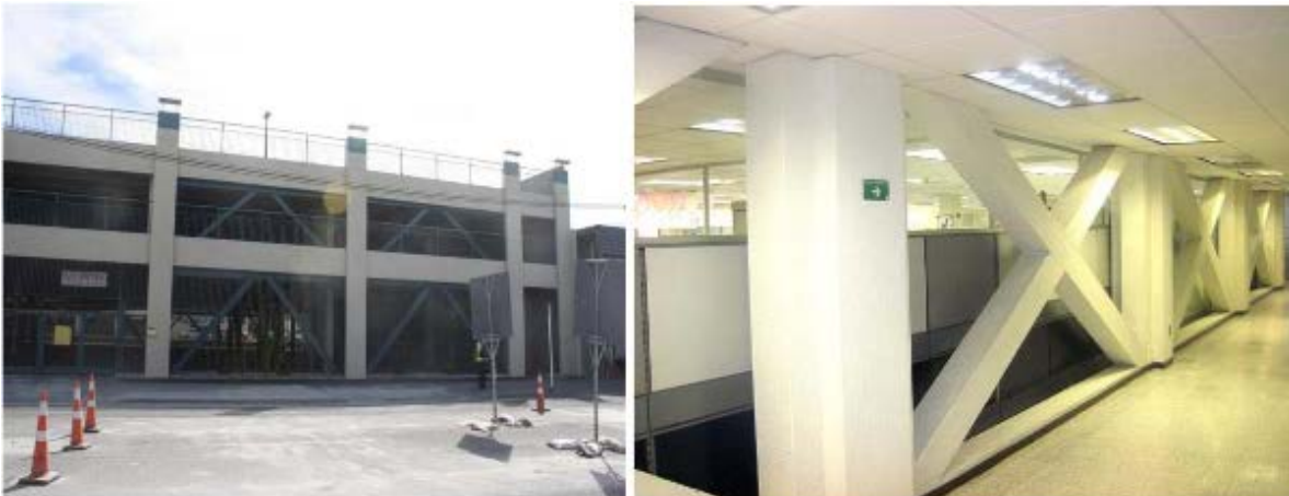
Figura A-4. Columnas y trabes de concreto con contraventeo: Izq. diagonales en el exterior y Der. diagonales en el interior
