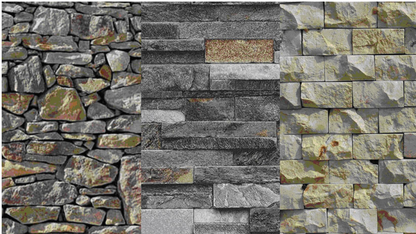
En muros con algún tipo de acabado pétreo no se aplicará ningún tipo de acabado adicional, se conserva el terminado aparente.
