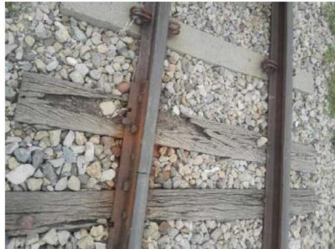
*Figura 15 Astilladura e intercalado de durmientes en vía*
